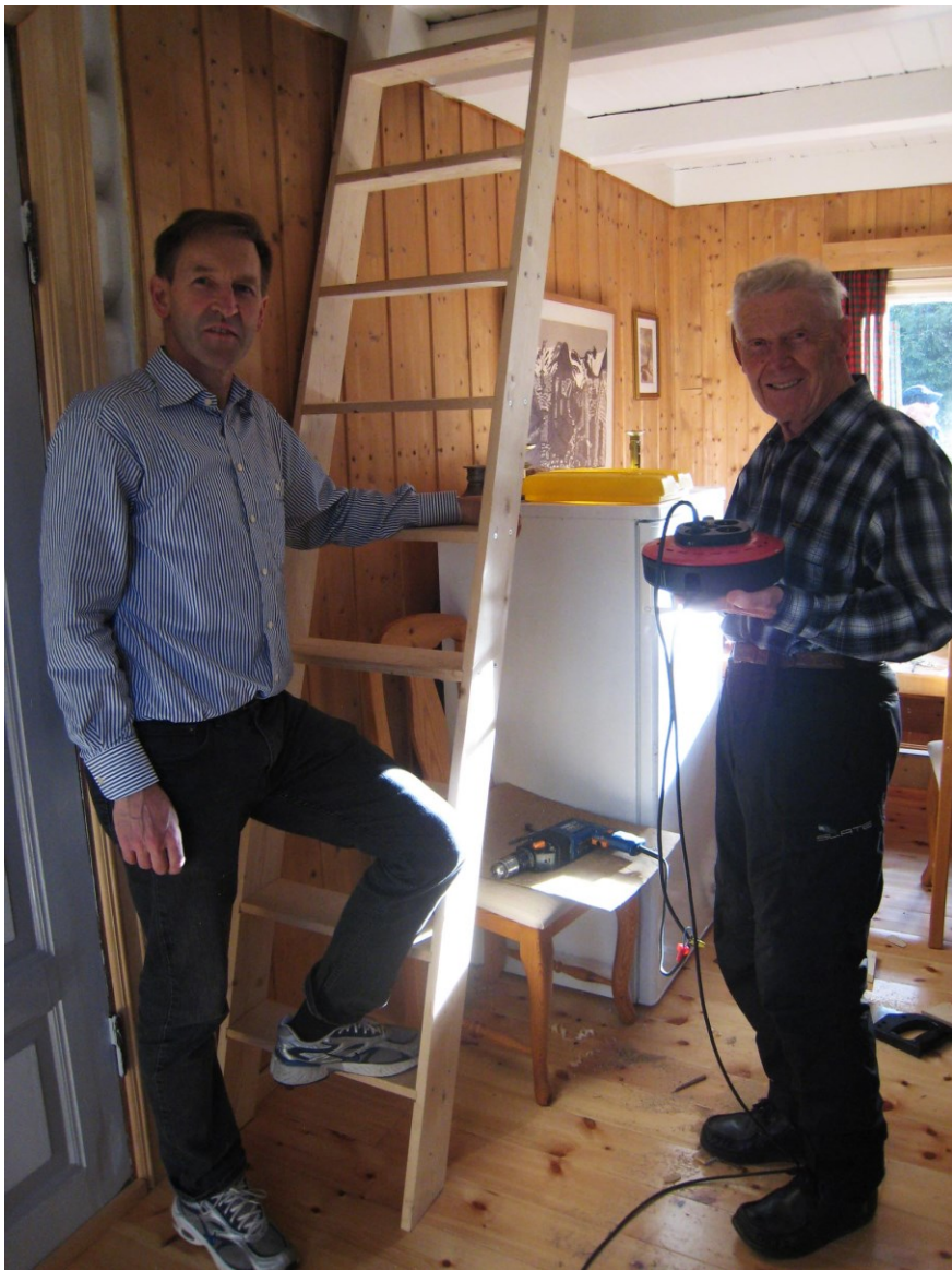
Innvendig er det store endringar, med nytt kjøken og fjerning av vegg mellom dette og veslestova. Golvet er også nytt i denne delen av hytta. Her har Birger Underdal, med hjelp frå Olav Kvam, nettopp sett opp hemstrappa som han har laga. Foto: Agnar Kvellestad.
